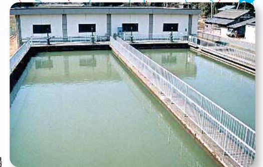
沢口導水ポンプ場
