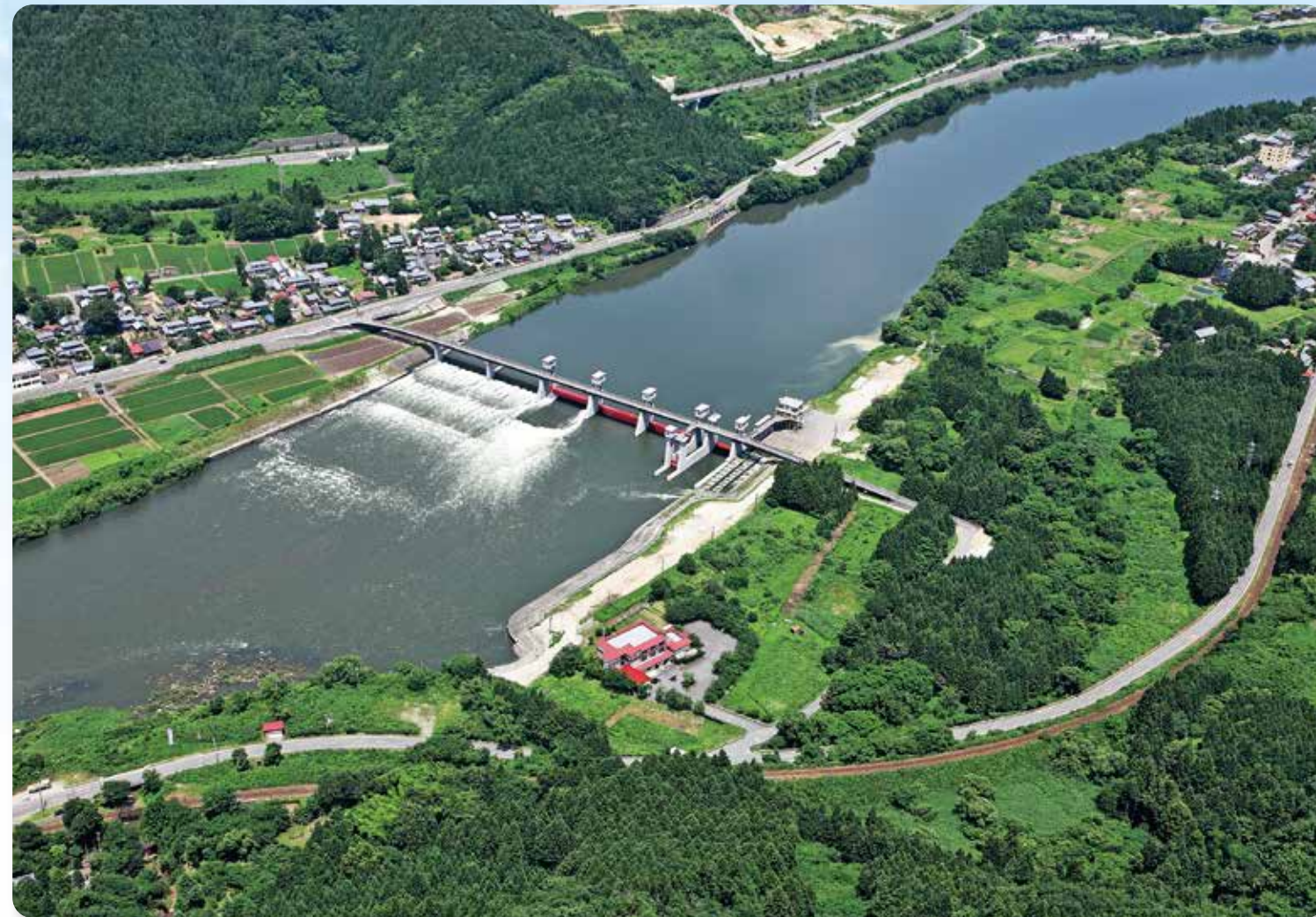
阿賀野川頭首工
