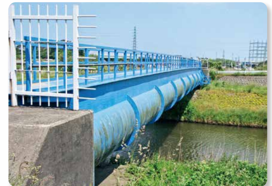
導水管(水管橋)
